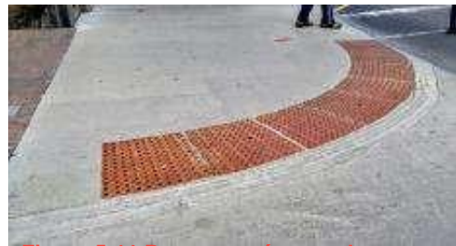
Figure 5-11 Bateau pavé avec plaques podotactiles
